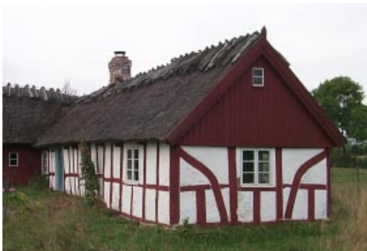
Fotot illustrerar tydligt korsvirkets rörlighet. Konstruktionen kan följsamt ta upp rörelser i väggar och grund.
