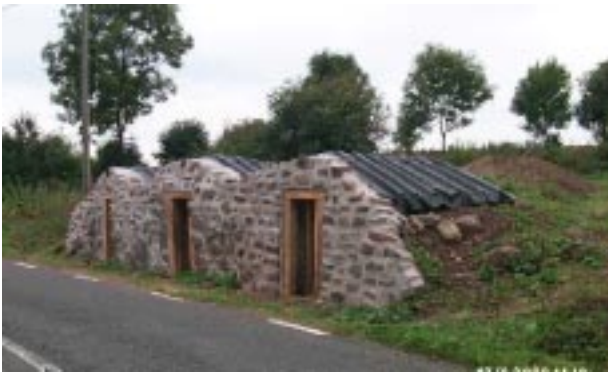
Jordkällarna vid vägen renoveras.
