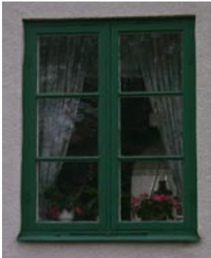
Exempel på fönster i Svanen.
