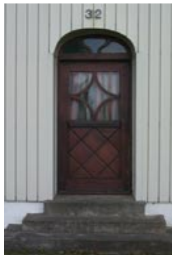
Detta är ett exempel på en byggnad som tilläggsisolerats med plåt men där den ursprungliga välarbetade dörren bibehållits.
