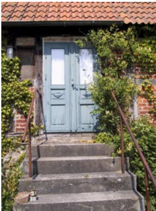
Entrén till den före detta bykrogen.
