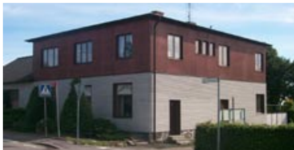
Onslunda 21:39. Den äldre byggnadens sockel av natursten är fortfarande synlig.
