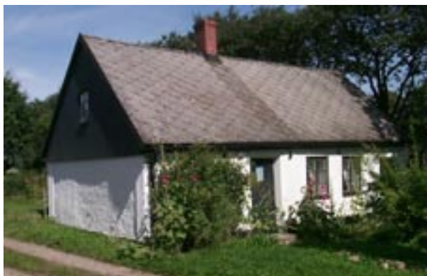
Onslunda 1:8. Notera de utskjutande bjälkäändarna på den övre delen av fasaden.
