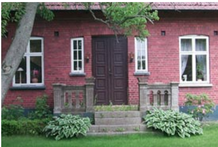
Entré med balustrad på 13:8
