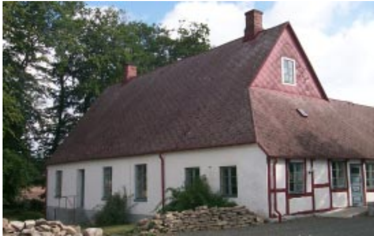
Bilden från Kverrestad visar skillnaden i byggnadsskick mellan den gamla prästgården från år 1795 och den nya uppförd år 1835 av tegel. Prästen hade byggnadsmässigt tagit steget från bättre bonde till herreman.
