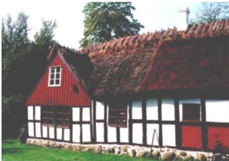
Glimmebodagården. Några av facken i korsvirket har fyllts med plank, båle, istället för lerkline.
