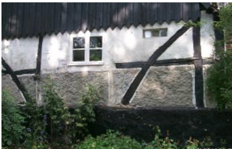
Stora kalkstensflisor i en korsvirkesvägg i Lunnarp.
